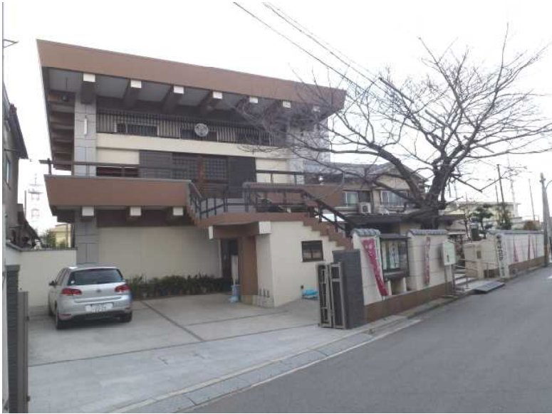
昭和四十年に再建された鉄筋二階建ての本堂
